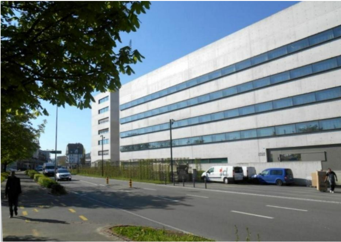
Bezirksgefängnis in Dietikon, Kanton Zürich. In den schalldichten Zellen dieses Betonbunkers werden auch Untersuchungshäftlinge wochen- und monatelang eingesperrt. Foto: Heinrich Frei
